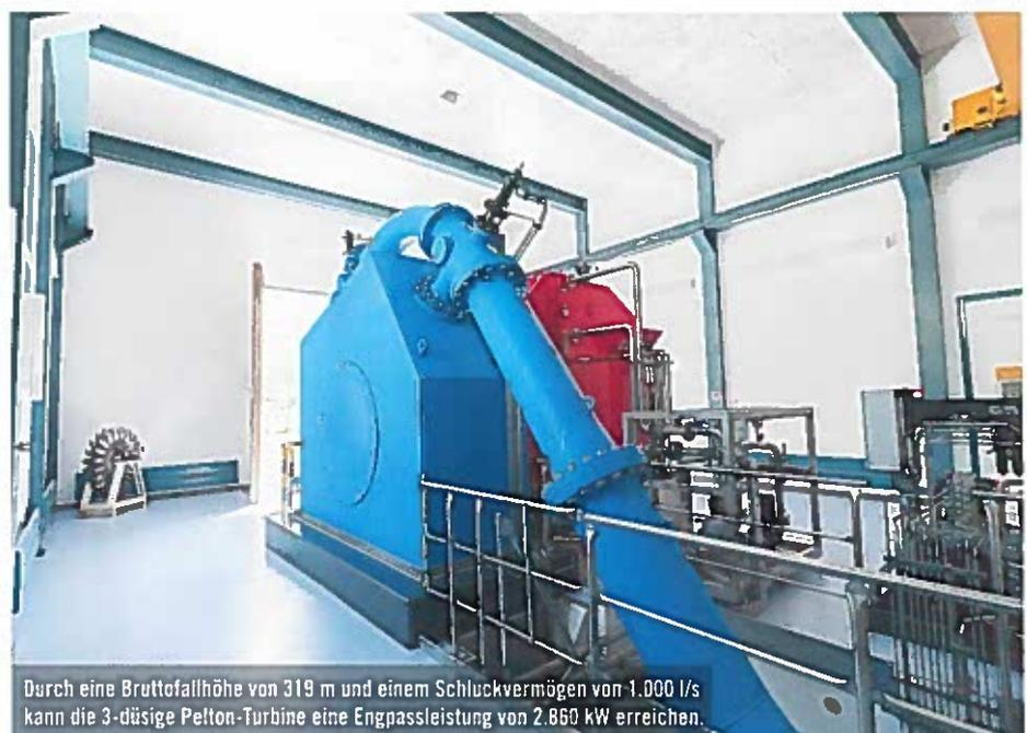
Durch eine Bruttofallhöhe von 319 m und einem Schluckvermögen von 3.000 l/s kann die 3-düsige Pelton-Turbine eine Engpassleistung von 2.860 kW erreichen.
