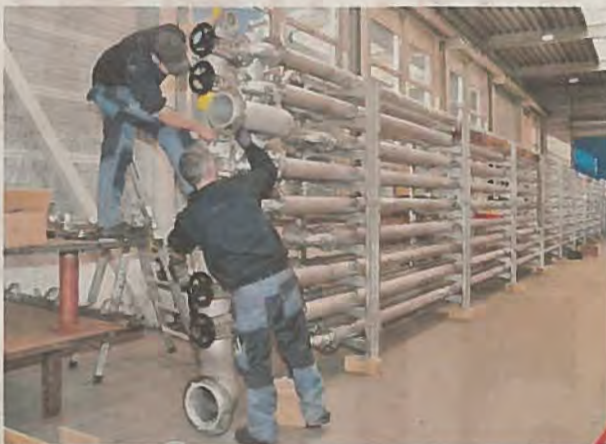
Wagner GmbH punktet mit innovativen Kühlanlagen im Kraftwerksbau – aktuell beim Großprojekt Obervermunt II. FOTO: MEZ
