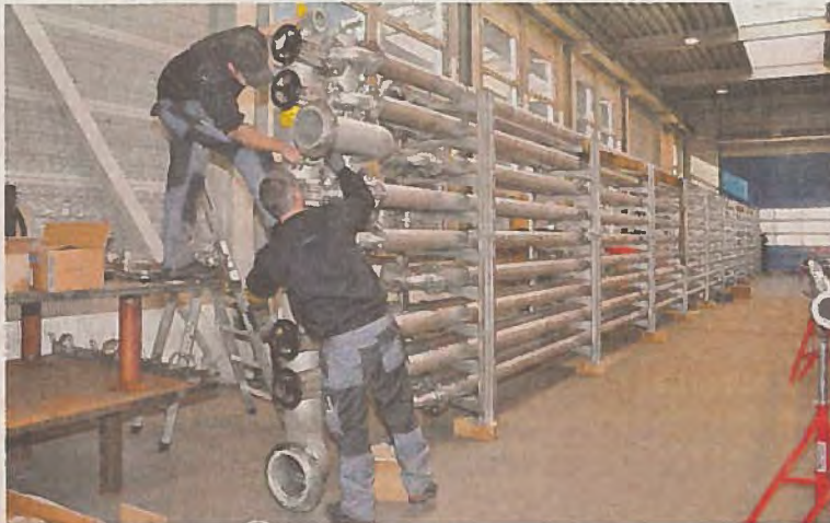
Die Nüziger Firma Wagner GmbH punktet mit innovativen Kühlanlagen im Kraftwerksbau, aktuell beim Großprojekt Obervermuntwerk II.
