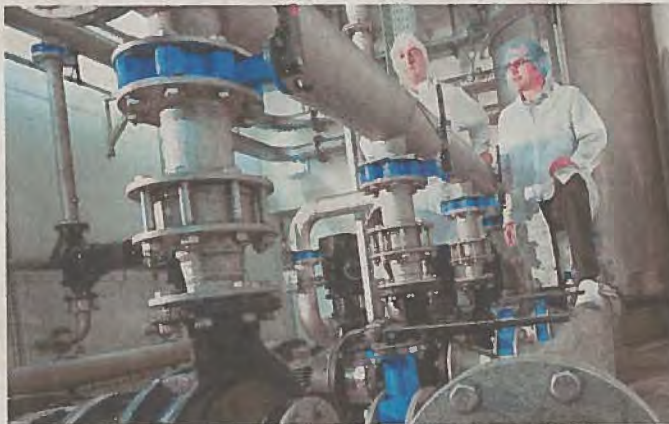
Bernd Predenz und Martin Wagner stehen vor der Eiswasserpumpstation mit Wärmerückgewinnung im Schokoladewerk Bludenz. VN/HARTINGER
