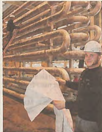
Letzte Arbeiten am riesigen Wärmetauscher.
